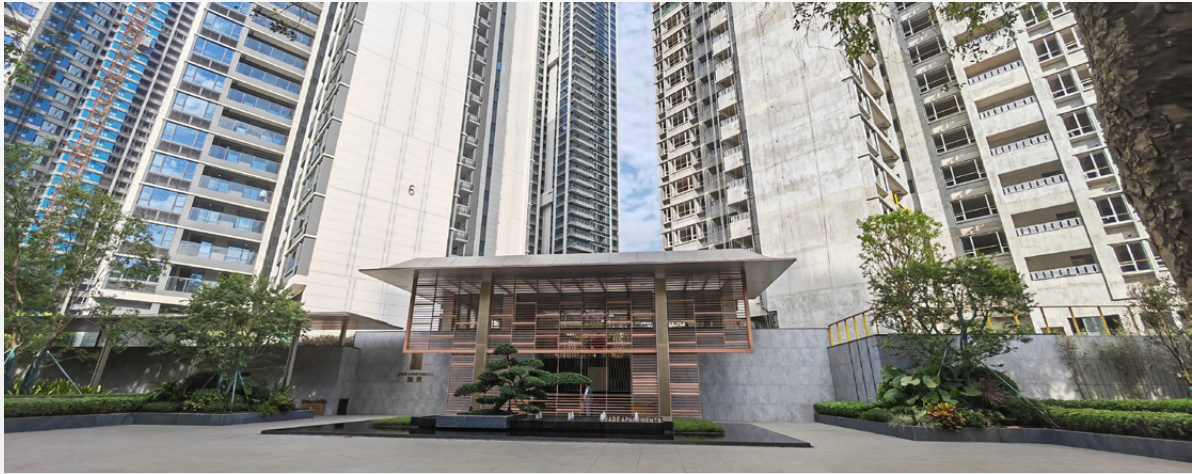
湛江旧大项目现场检查
